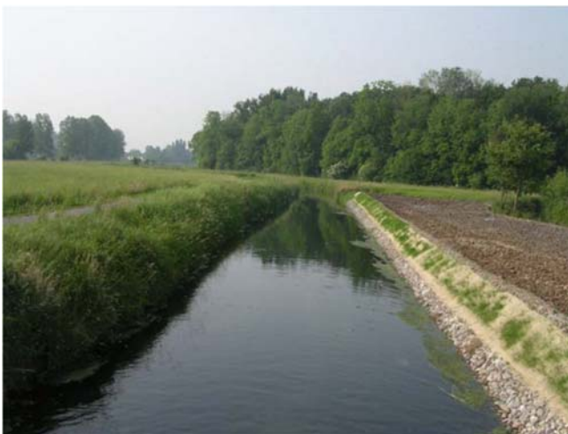
Fig. 2-3: Impiego di materassi in rete metallica associato all'uso di rete e geocompositi contro l'intrusione di nutrie e gamberi nei rilevati arginali di canali e fiumi – 2011- Applicazione pratica a cura di Borghi Azio spa
