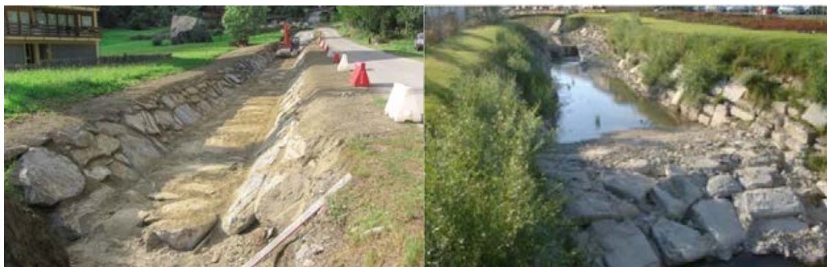
Fig.1-2 Realizzazione soglie in blocchi o massi ( fonte: www.factor20.it – Ream Recupero ambientali)
