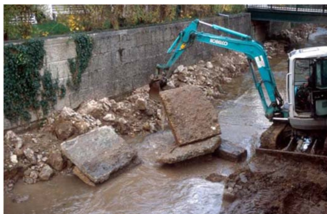
Fig. 4-5 - Esperienze viennesi del Prof. Florineth . Tratto del fiume Mödling (Vienna) prima dell'intervento di rivitalizzazione e durante la demolizione dell'alveo cementificato .Foto F. Florineth. (Fonte: Linee Guida Riqualificazione Canali, Regione Emilia Romagna)
