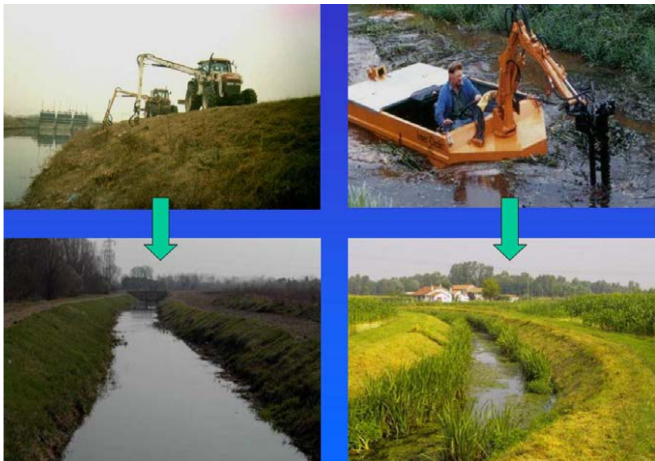
Fig. 1- Sistemi di manutenzione tradizionali e "gentili": a confronto il risultato delle operazioni (da "Il caso dei canali irrigui e di bonifica: tecniche ed esempi applicativi di riqualificazione idraulico-ambientale", ing. M. Bacci, 2005)
