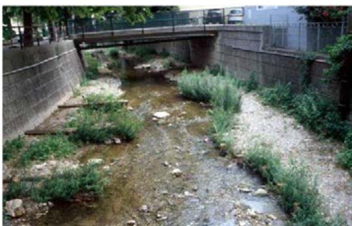
Fig. 6-7 - Tre mesi e tre anni dopo la costruzione di repellenti con tronchi e fascine orizzontali (a sinistra) e fascinata longitudinale (a destra). Foto F. Florineth. (Fonte: Linee Guida Riqualificazione Canali, Regione Emilia Romagna)
